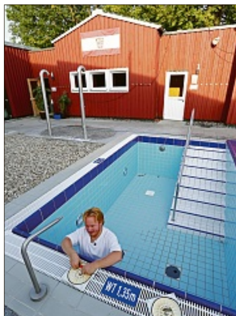
Die Abflüsse überprüft Rick Kühnhenn in einem Außenbecken der Sauna.
