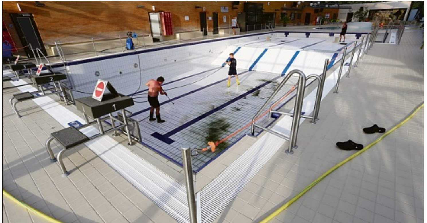
Mit Hochdruckreinigern säubern die Mitarbeiter das große Becken.
