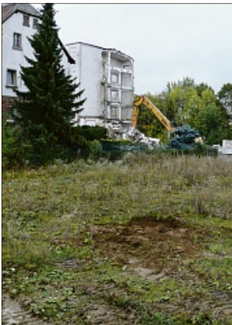
In unmittelbarer Nachbarschaft wurde das ehemalige Silogebäude der Urbansmühle abgerissen.
