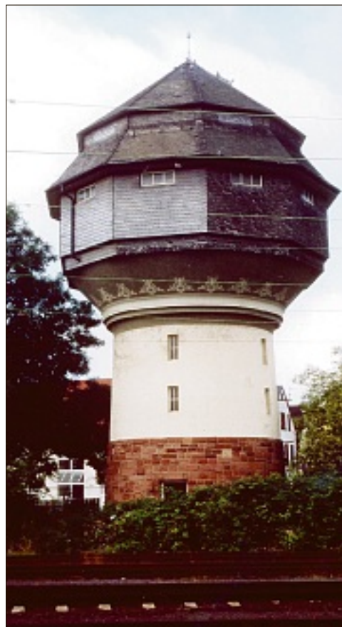
Der Wasserturm von der Gleisseite im Jahr 2001. (Foto: Georg Böhm)
